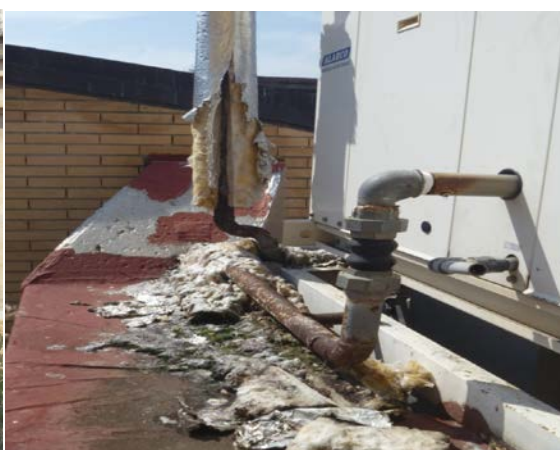
Ilustración 7: Foto del mal aislamiento.
