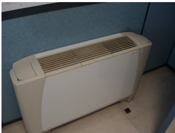
Ilustración 19: Foto Fancoil
