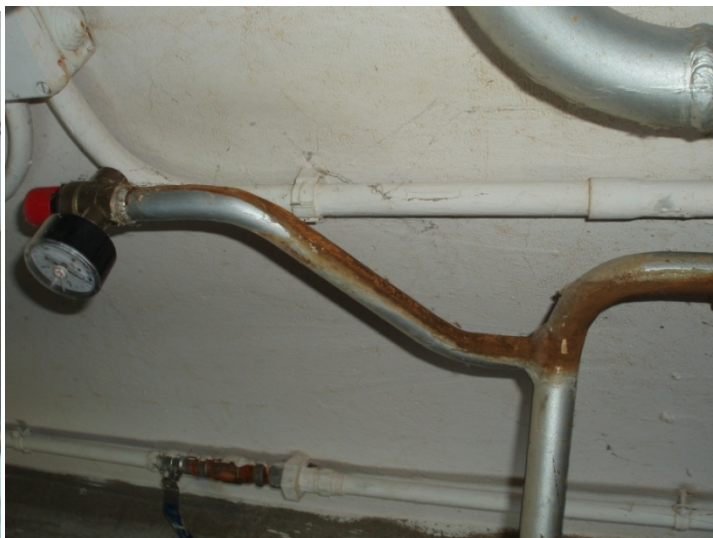
Ilustración 28: Foto óxido por fugas.
