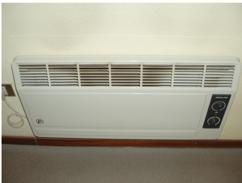
Ilustración 24: Foto radiador eléctrico HAVERLAND
